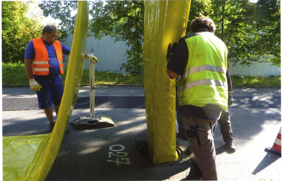
Effizientes Einziehen des DN 1100 Liner.
