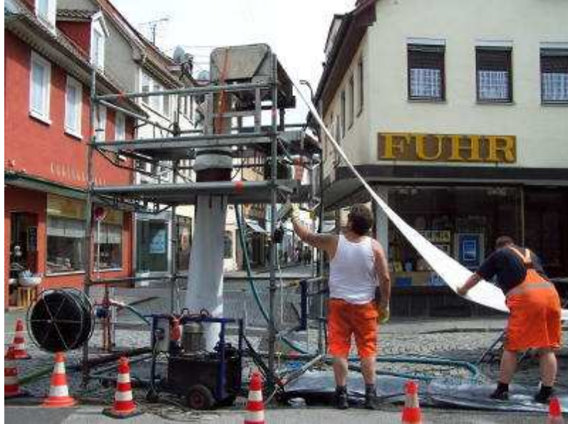
Vorletzte Station der Kanalsanierungsarbeiten in der Innenstadt: die Kanzleistraße. FOTO: STEFAK
