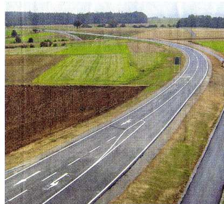
Blick auf die L 1361 in Richtung Autobahn 81. Mit der neuen Straße werden die Bewohner zweier Gemeinden entlastet. Foto: Regierungspräsidium Stuttgart
